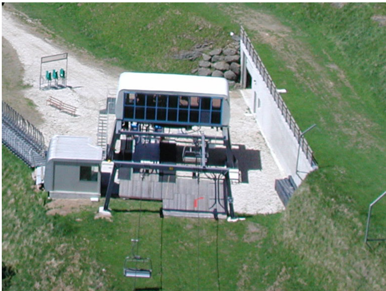
stazione di valle
