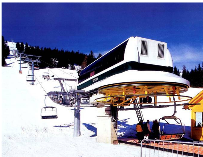
stazione di valle
