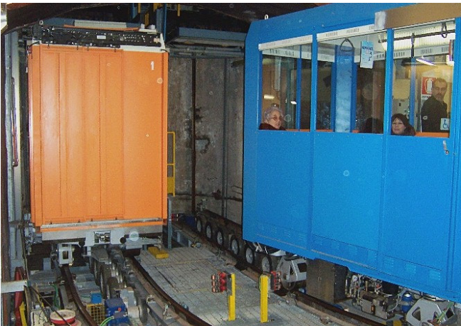
passaggio dal tratto funicolare alla fossa ascensore
