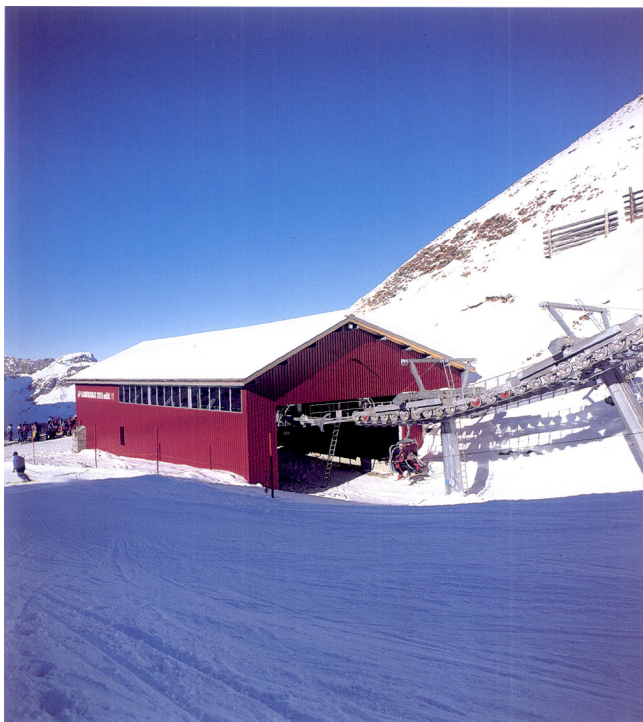
stazione di valle
