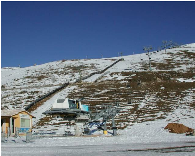
stazione di valle
