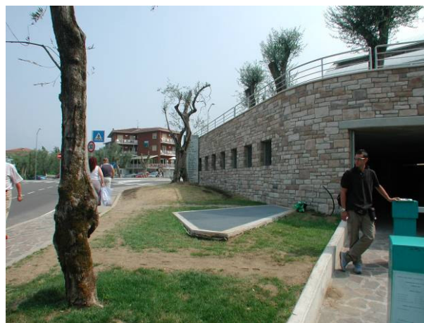
ingresso al parcheggio sotterraneo
