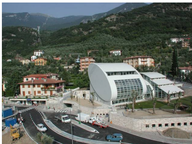
stazione di valle
