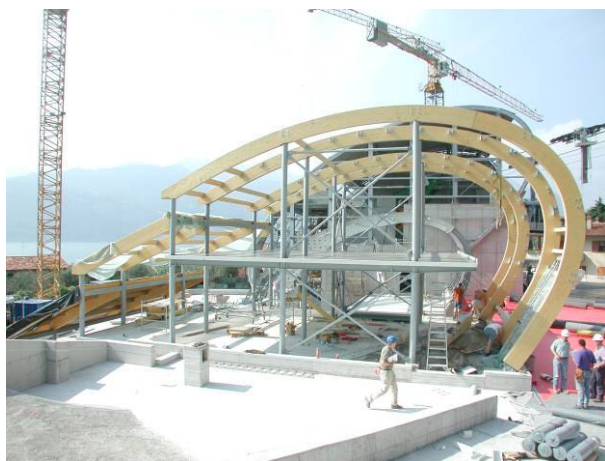
costruzione della stazione di monte
