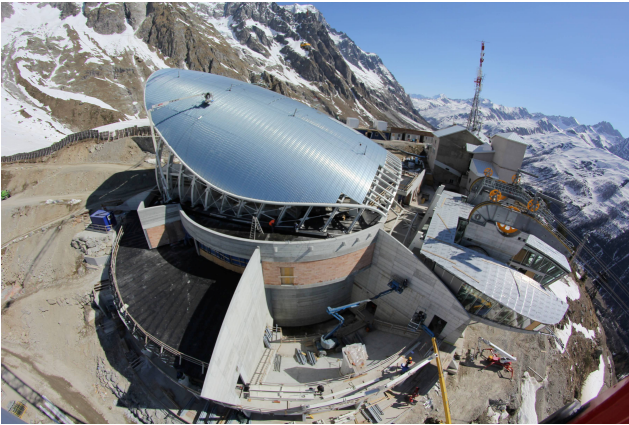
Baustelle der Talstation (Mittelstation)
