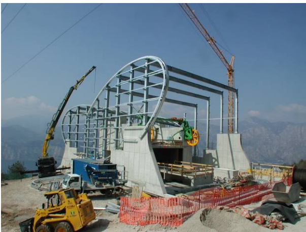
Baustelle der Mittelstation
