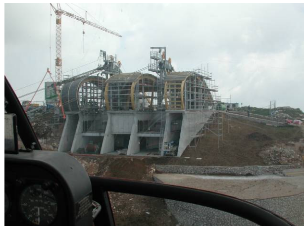
Baustelle der Bergstation
