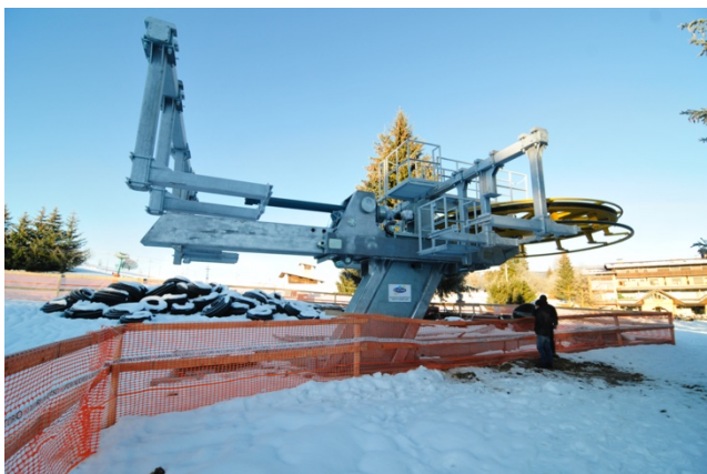
Costruzione della stazione di valle
