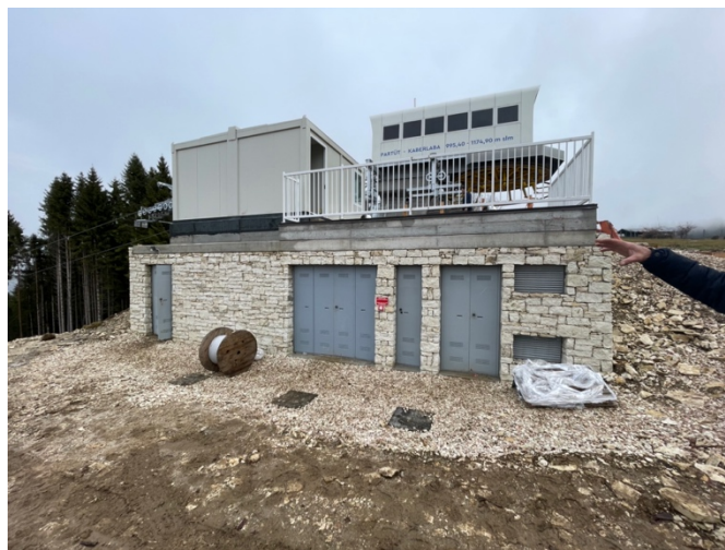
Costruzione dei locali interrati a monte
