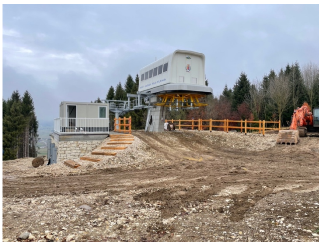
Costruzione della stazione di monte
